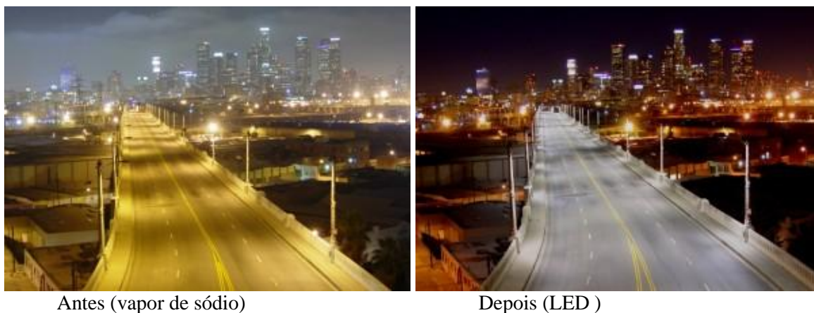
Figura 1 Transição de lâmpada Vapor de Sódio para Tecnologia LED
